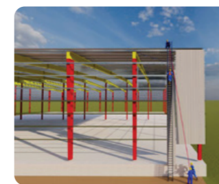
Lắp đặt tôn vách
