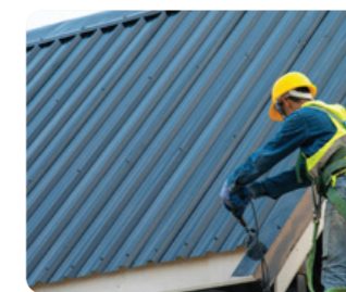
Công tác hoàn thiện
