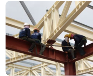
Lắp đặt kết cấu
