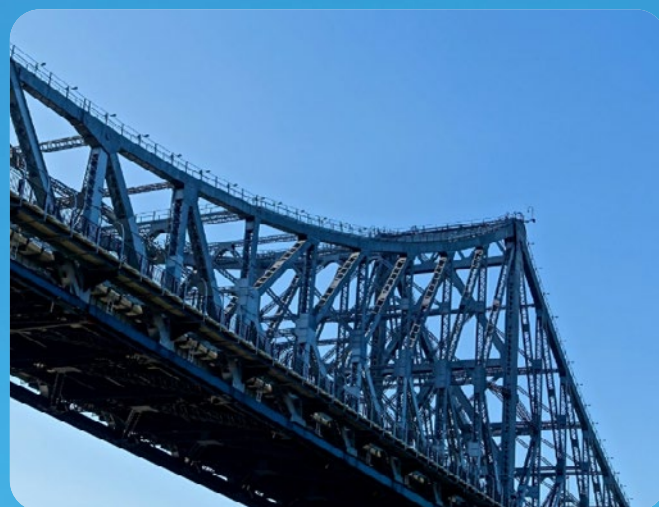
CƠ SỞ HẠ TẦNG
