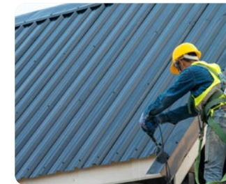
Công tác hoàn thiện
