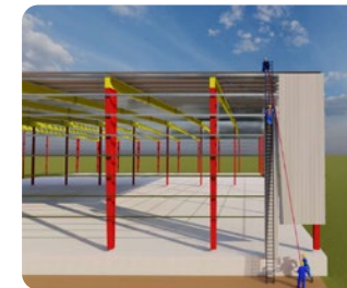
Lắp đặt tôn vách
